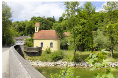
St. Nikolauskapelle an der Amper
