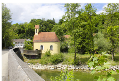
St. Nikolauskapelle an der Amper
