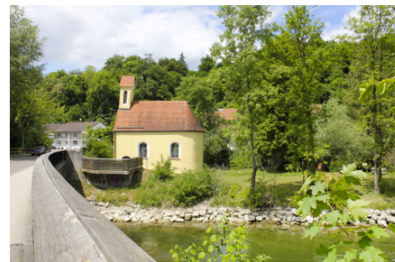
St. Nikolauskapelle an der Amper
