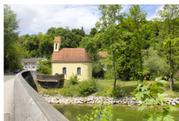
St. Nikolauskapelle an der Amper
